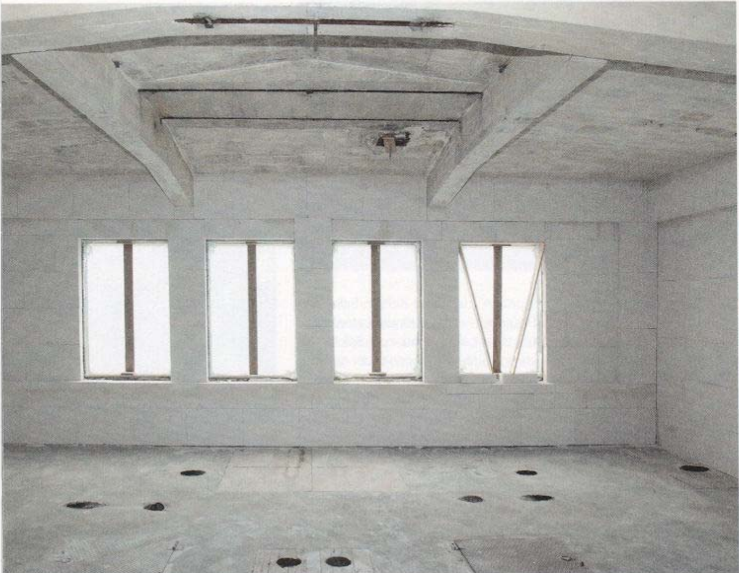
Die leicht zu bearbeitenden Mineraldämmplatten ließen sich problemlos auf die vorgefundene Wandkonstruktion aufkleben.
