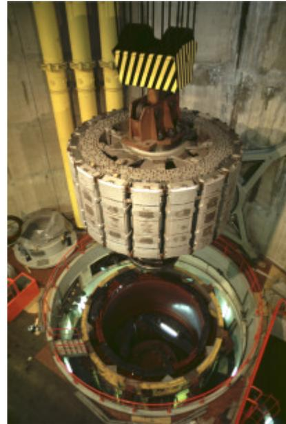
10.Maschine: Demontage des Rotors
