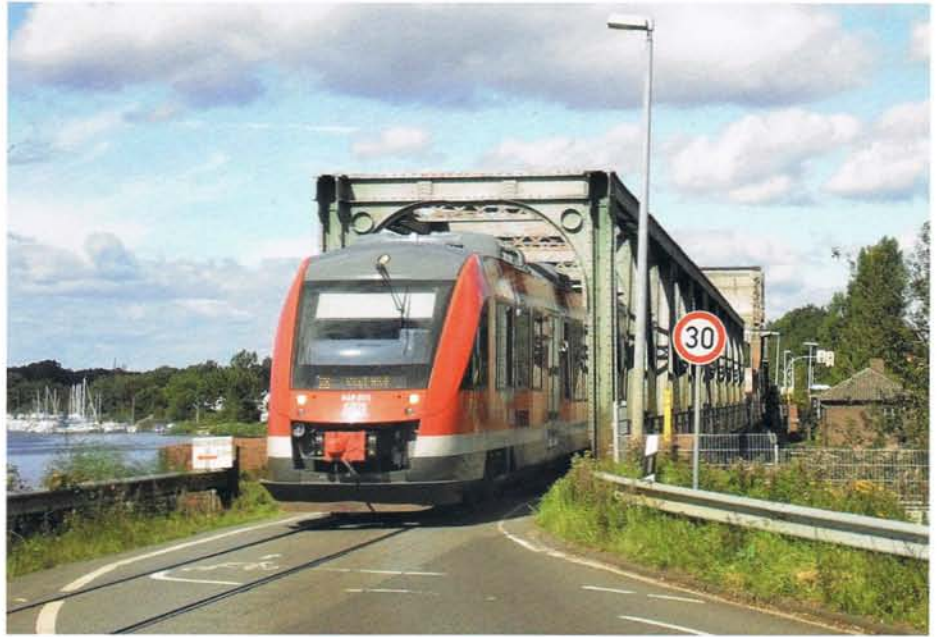
Am 2. September 2011 passiert 648 955 nach Kiel die Schleibrücke in Lindaunis.
